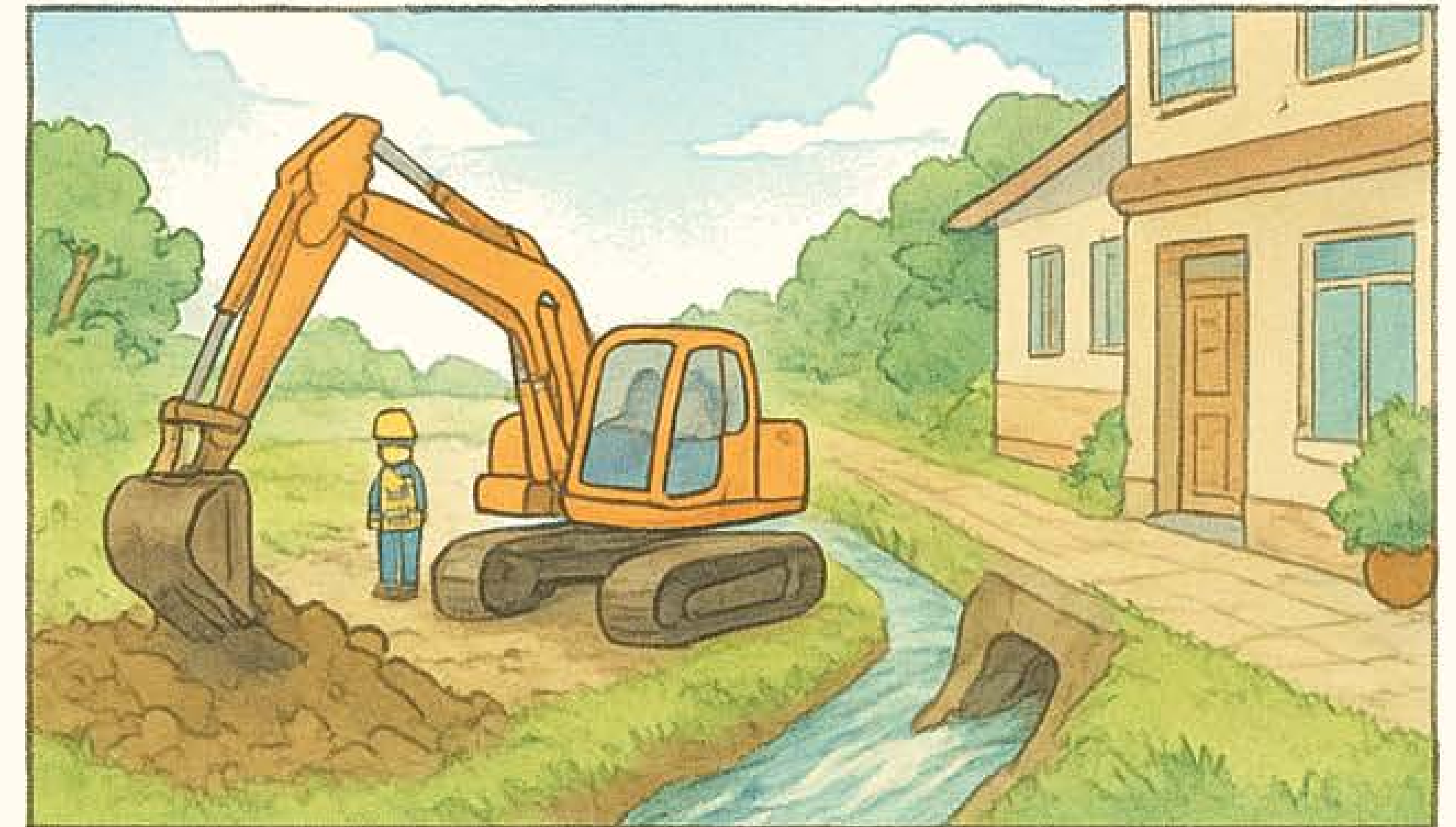
Xây dựng cống ngăn triều để kiểm soát mực nước và ngăn triều cường vào nội địa
