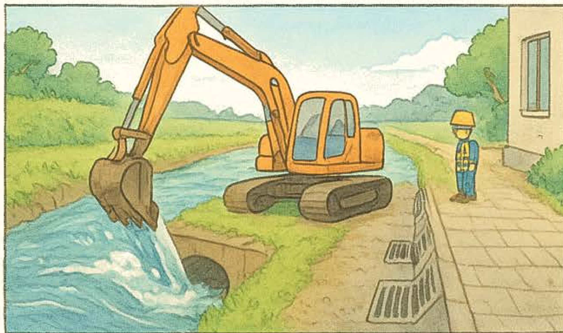
Xây dựng cơ sở hạ tầng
